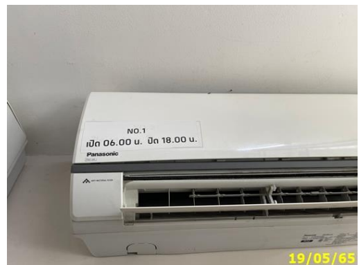
เครื่องปรับอากาศประหยัดพลังงาน พร้อมกำหนดเวลาเปิด-ปิด
